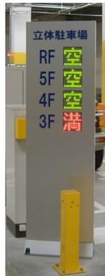
入口にそれぞれ、各フロアの空き状況が一目で分かる、超薄型アルミハニカム製の満空表示板を設置。
