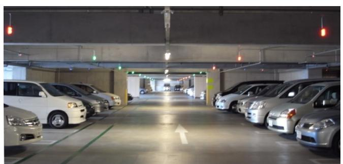
【上写真】約3車室に1個の割合で設置された招き灯は、周囲に1台でも空き車室があれば、「緑」に点灯します。
