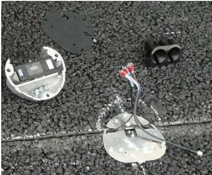
結線及び、センサベースの固定
