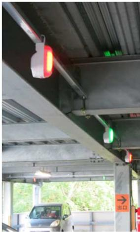
車室前方に張ったレースウェーに、1車室に1個のEP-IVを設置。
