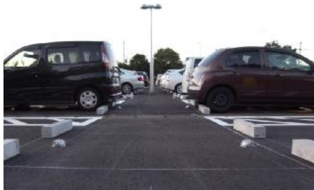
【上写真】センサーは、アスファルト塗装後、簡単なカット工事で設置されます。
