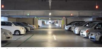
【上写真】約3車室に1個の割合で設置された招き灯は、 周囲に1台でも空き車室があれば、「緑」に点灯します。
