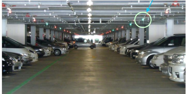
柱間の駐車スペースが全て在車の場合は「赤」に点灯、一台でも空きがあると「緑」に点灯してお客様を誘導します。球切れの心配の殆ど無いLEDランプを使用。
