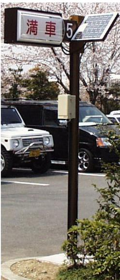
センサーの情報をもとに、満車、空車を表示させます。
