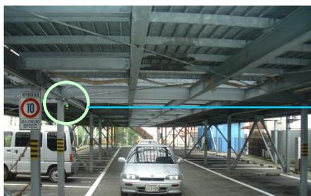
柱間の駐車スペースが全て在車の場合は「赤」に点灯、一台でも空きがあると「緑」に点灯してお客様を誘導します。球切れの心配の少ないLEDランプを採用。
